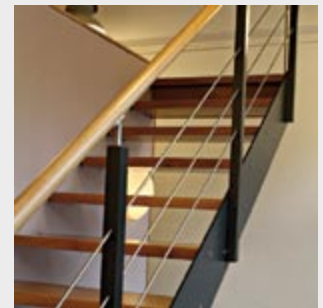
Reling mit Edelstahlstangen und Vierkantpfosten
